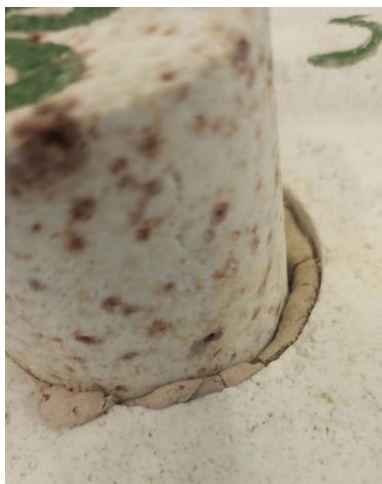
Figuur 34, dakleer na proef cylinder nog er op
