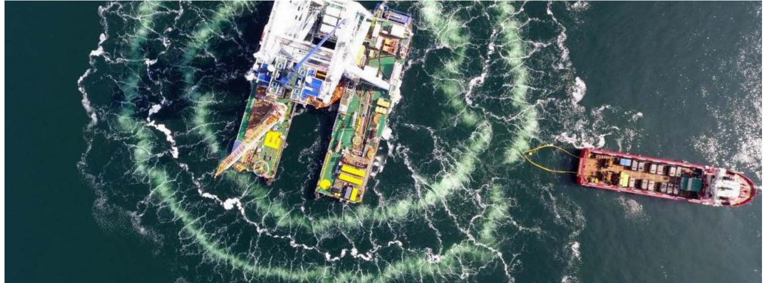
fig. 4.5 - Van Oord's Svanen. Foto: Van Oord.
