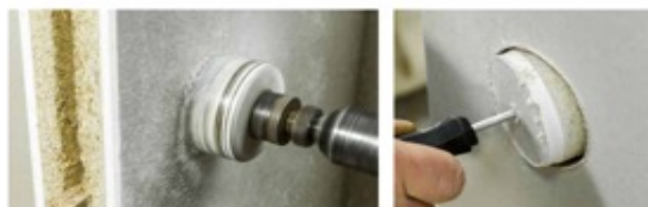
Elektra We hebben met een gatzaag de opening voor de elektriciteit en waterleiding aan het materiaal. Hierop kan de leding worden gemonteerd en de draad aangesloten. De weer is nu geschikt voor andere afwerking, denk aan het plaatsen van een plint of het aanbrengen van een afwerkingslaag van een andere afwerking, zoals een vloer, wand, plafond, tegels, behang, glasvezel of stucwerk. Meer informatie: www.fayati.nl
